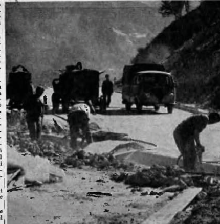
Un gruppo di operai su un cantiere della Tremola
